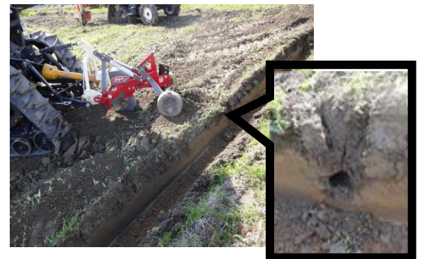
写真 額縁排水溝に連結した暗渠
